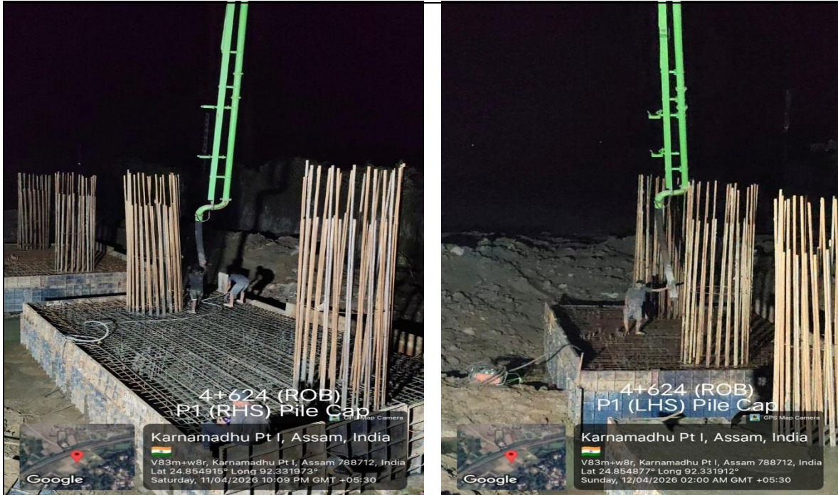
ROB P1(BHS)- Pile Cap Concrete Pouring
