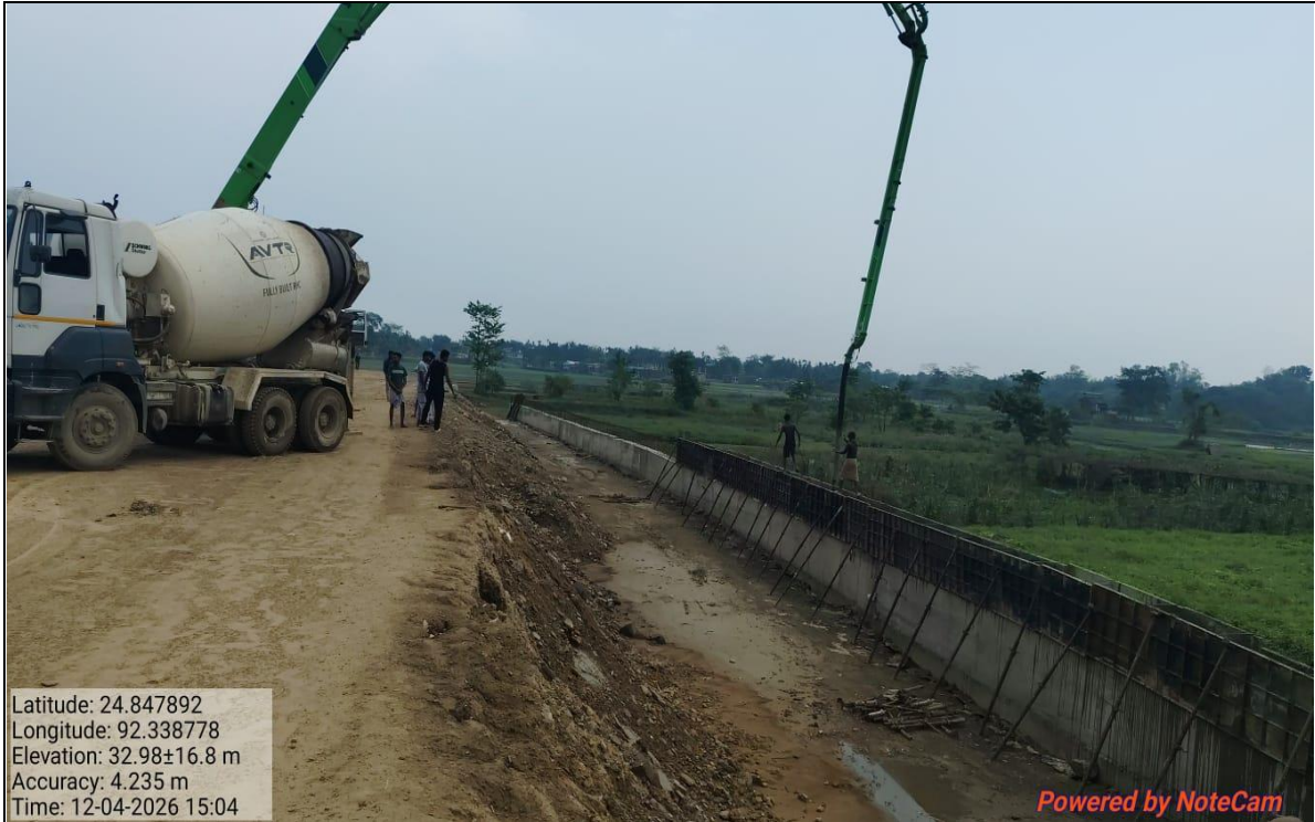
TOE WALL Concrete Pouring
