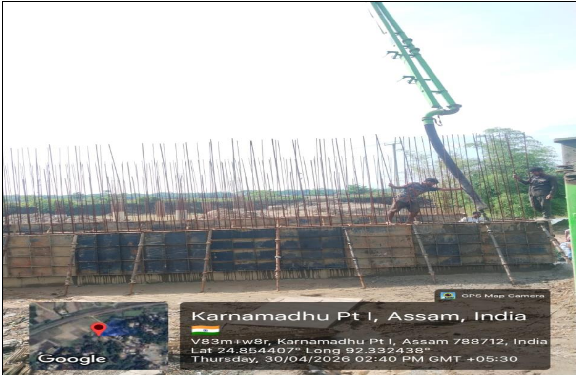
BUP- 1 ST Lift Concrete Pouring Ch- 04+534
