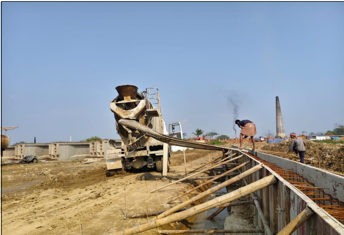
TOE WALL CONCRETE POURING At CH- 00+450 LHS
